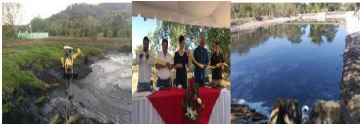
Fig. 23 Rehabilitación e inauguración de sistema de tratamiento de aguas residuales
