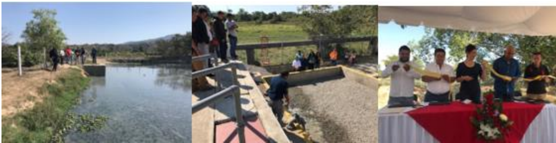
Fig. 30.- Rehabilitación de Sistema de Tratamiento de Aguas Residuales (sistema Anaerobio de Flujo Ascendente Humedal) en el Municipio de Cabo Corrientes
